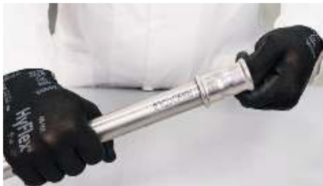
Рис. 31. Вставка трубы в пресс-фитинг.
