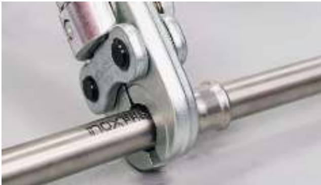
Рис. 32. Опрессовка.
