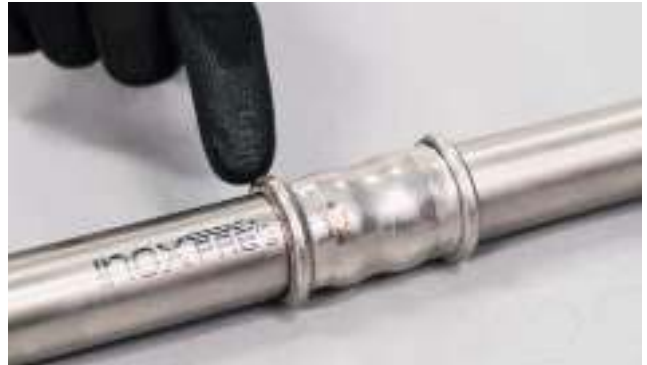
Рис. 33. Проверка пресс-соединения.
