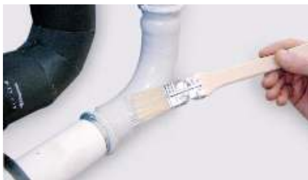
Рис. 37. Покраска соединений и труб праймером.
